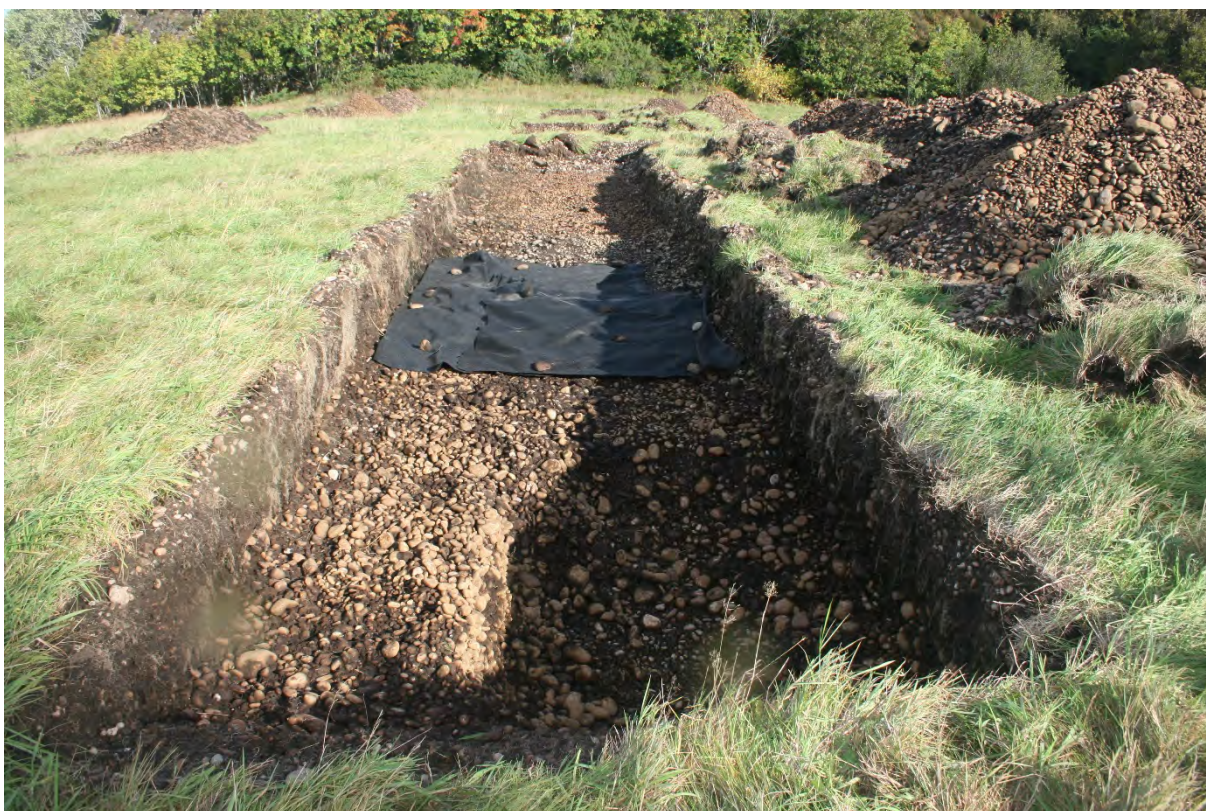
Figur 36: Før igjenfylling av sjakten ble struktur 3A dekket med fiberduk. Bildet er tatt mot nordøst. Foto: Heidi Eltoft
