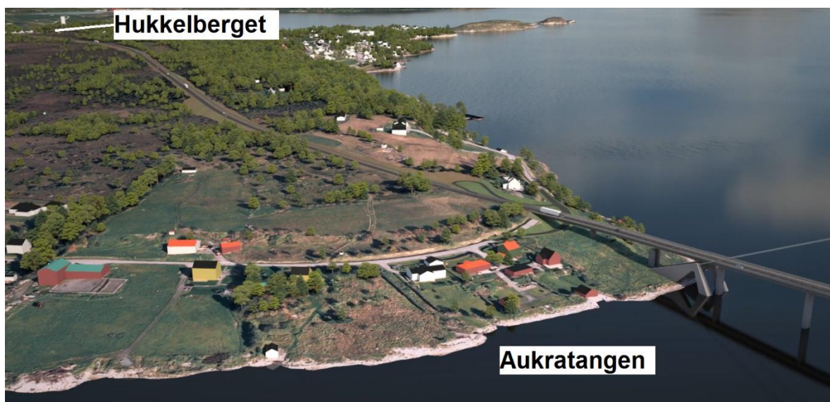
Figur 12 Vegtrase fra Aukratangen og nordover mot Hukkelberget
