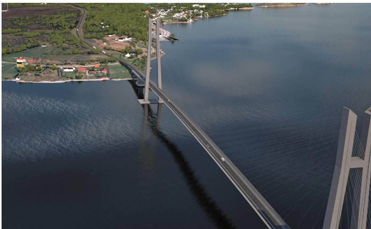
Figur 38 Alternativ skråkabelbru i Kjerringsundet
