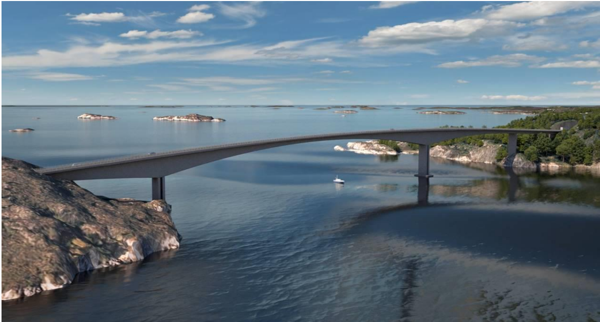
Figur 36 Fritt frambyggbru i Bollholmsundet
